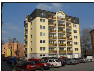
Bytový dům panelový a zděný bez dostatečných podkladů pro zpracování PENB
