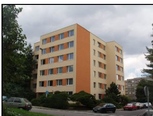
Bytový dům panelový a zděný s dostatečnými podklady pro zpracování PENB
